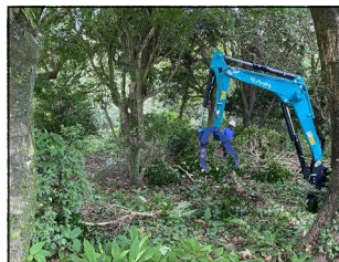
重機による伐採作業
