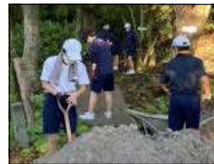
生徒たちによる作業の様子
