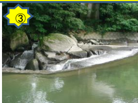
大田大橋付近
