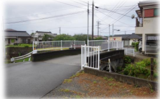
9月に安全柵が完成した汐見橋
