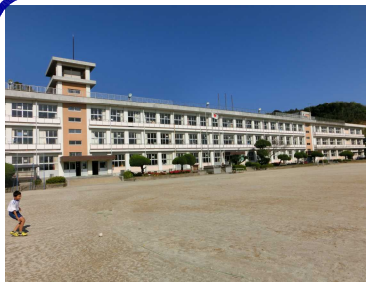
S39.2鉄筋3階校舎上棟から50年
