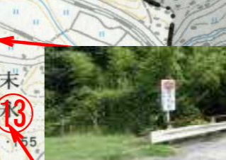
13 窪田 米丸踏切先橋と川淵 左手は柵も無く、落 下の危険あり
