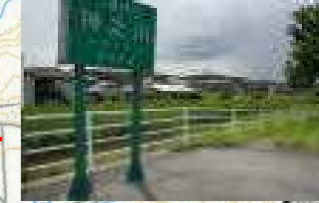
11 清藤 清藤橋と排水側溝 欄干に乗って遊ぶと 転落の危険大
