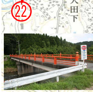
21 大田中 報恩寺橋付近の川 土手が急で石ころ も多い
