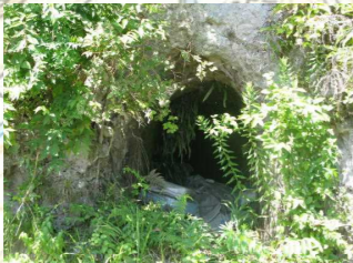
23 瀬戸内 三高建設近く シラス崖防空壕あり、崩 れる可能性もある
