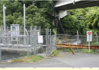
22 大田下 発電所付近の川 水門、岩場、高圧電線 あり、危険
