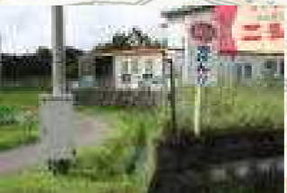
2 宮脇 道路沿い用水路 雨天時は増水し危険
