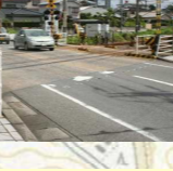
16 麓東 小諏訪踏切 遮断機無し
