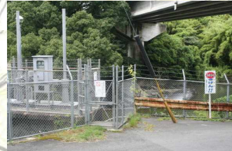
22 大田下 発電所付近の川 水門、岩場、高圧電線 あり、危険
