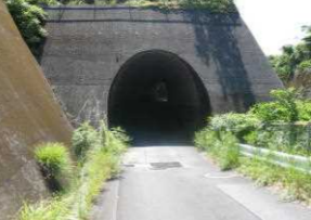
24 瀬戸内 代用道路を整備し てトンネルは封鎖
