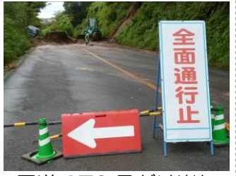
国道270号がけ崩れ
