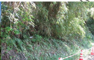
がけ崩れ、土砂崩れ
