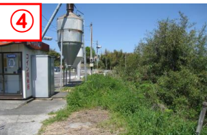
④ 立入禁止 (かけ崩れ)
